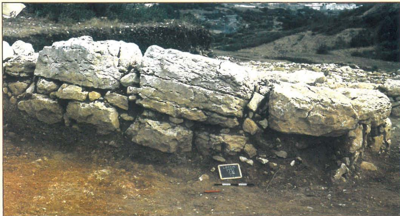
Fig. 15 - Grandes blocos calcários, utilizados no embasamento de um dos bastiões da primeira linha defensiva.
