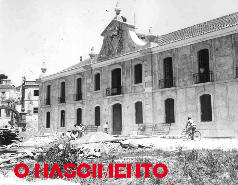
Obras de adaptação para os atuais Paços do Concelho, 1940. Arquivo SIMAS.
