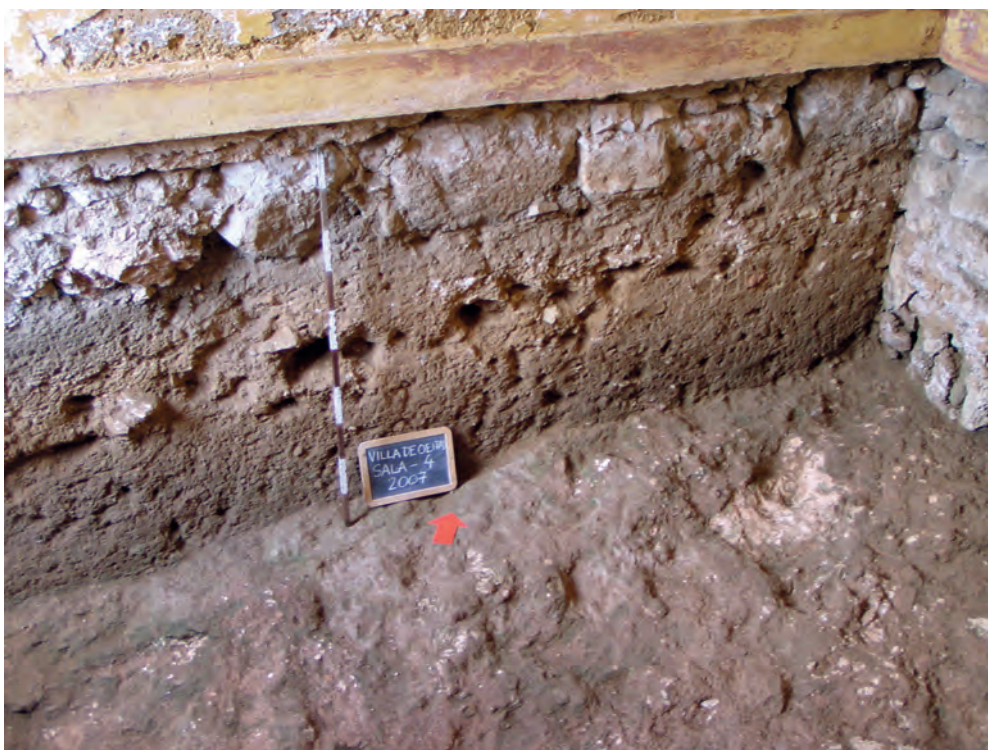
Fig. 9 – Sala 4. Corte estratigráfico observado ao longo da parede setentrional da sala, observando-se do lado direito o embasamento de parede mestra, fundada no substrato geológico, do edifício de origem setecentista. O enchimento terroso, sobre o qual assenta parede divisória do piso térreo do edifício, marcada por uma régua de madeira correspondente ao antigo rodapé, contém materiais de todas as épocas e é posterior à fundação da parede mestra do edifício, podendo assim ser datado do século XIX. (foto de João Luís Cardoso).
