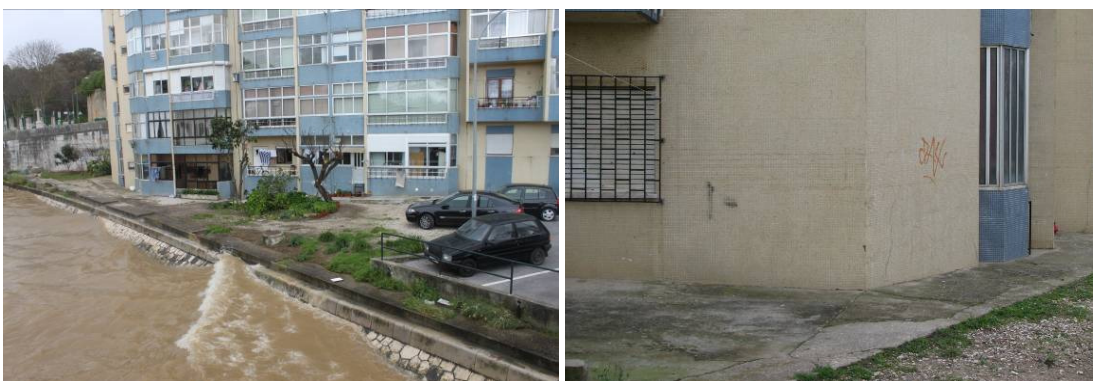
Figura 72- Edificações na margem esquerda do rio Jamor, na foto à esquerda pormenor da marca no prédio (Fonte: GEOTPU, 2010)
