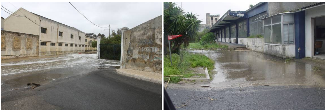
Figura 68 – Alagamento na entrada Gist Brocades no dia 27 de Fevereiro de 2010
