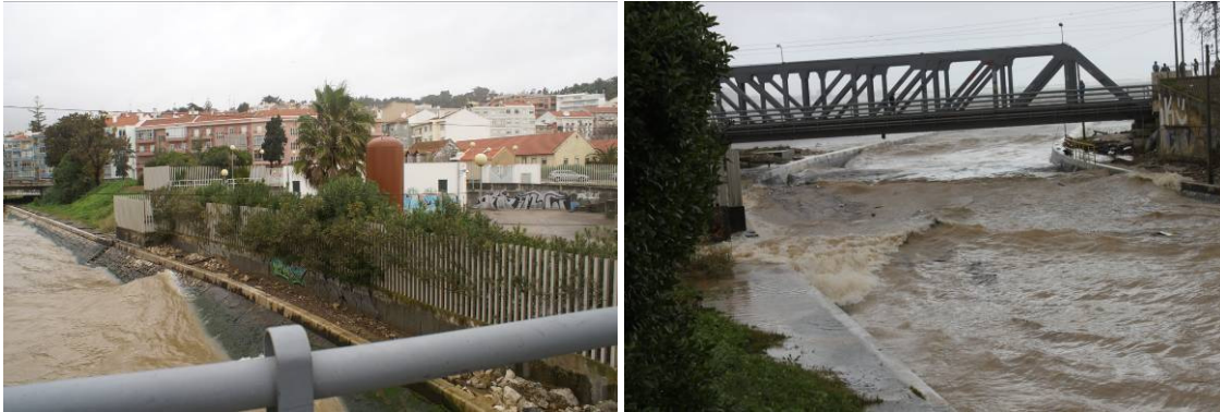
Figura 73 – Margem esquerda na zona da Estação Elevatória do Jamor (Fonte: GEOTPU, 2010)
