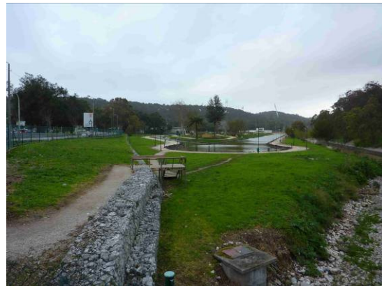
Figura 45 – Leito de cheias na margem direita do rio Jamor a montante da ponte da Av. Pierre de Coubertin - vista para montante
