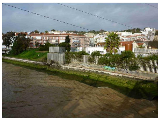
Figura 46 – Leito de cheias na margem esquerda do rio Jamor e secção regularizada do rio Jamor entre a ponte da Av. Pierre de Coubertin e a ponte da REFER - vista para montante
