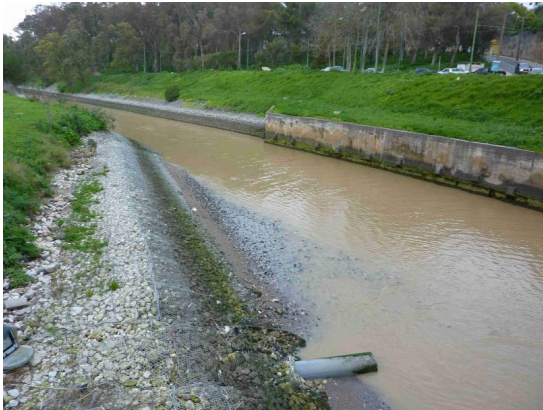
Figura 44 – Secção regularizada do rio Jamor a montante da ponte da Av. Pierre de Coubertin - vista para montante
