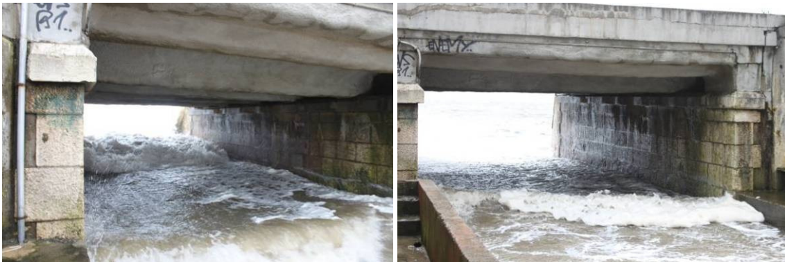
Figura 80 – Inundação da passagem inferior pedonal (Fonte: GEOTPU, 2010)
