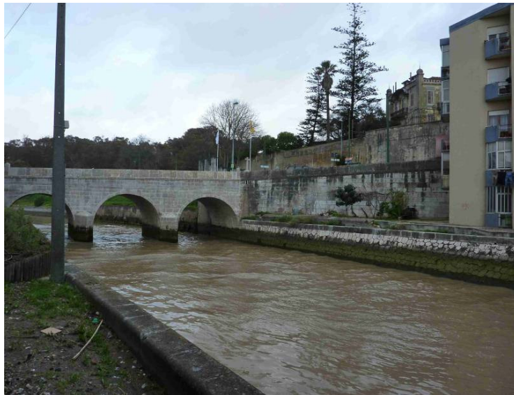
Figura 43 – Ponte da Av. Pierre de Coubertin - vista para montante
