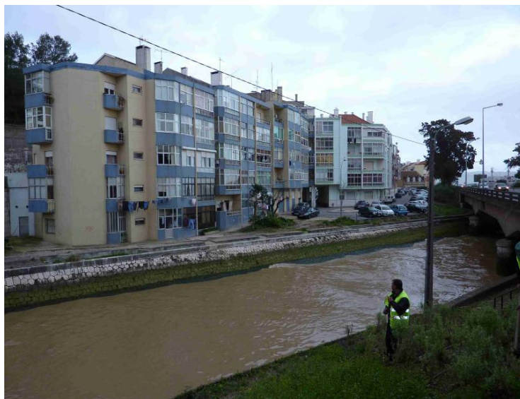
Figura 49 – Leito de cheias na margem esquerda do rio Jamor a montante da ponte da Av. Marginal - vista para montante
