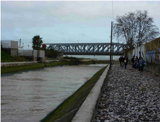
Figura 41 – Ponte da REFER – vista para jusante
