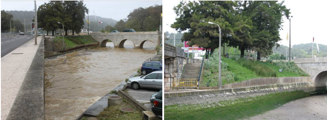
Figura 70 - Margem direita do rio Jamor antes da Ponte da Avenida Marginal
