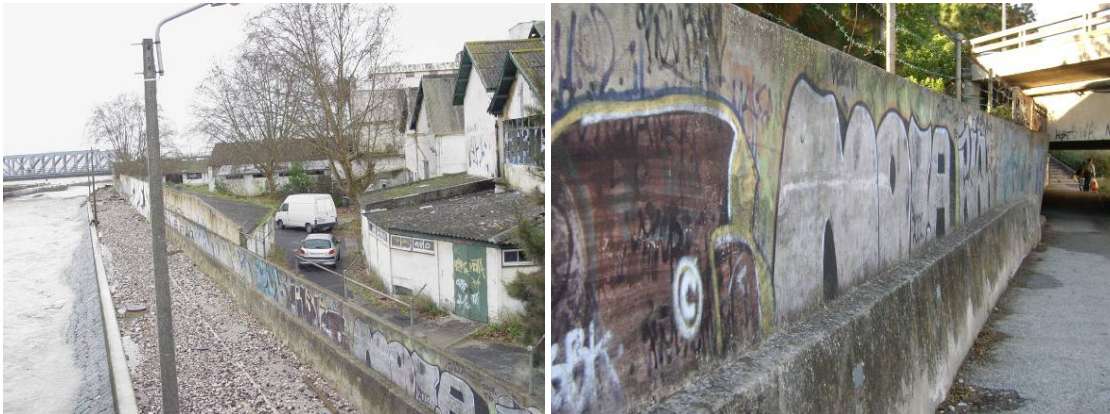
Figura 71 – Margem direita do rio Jamor entre a Ponte da Avenida Marginal e a Ponte da REFER
