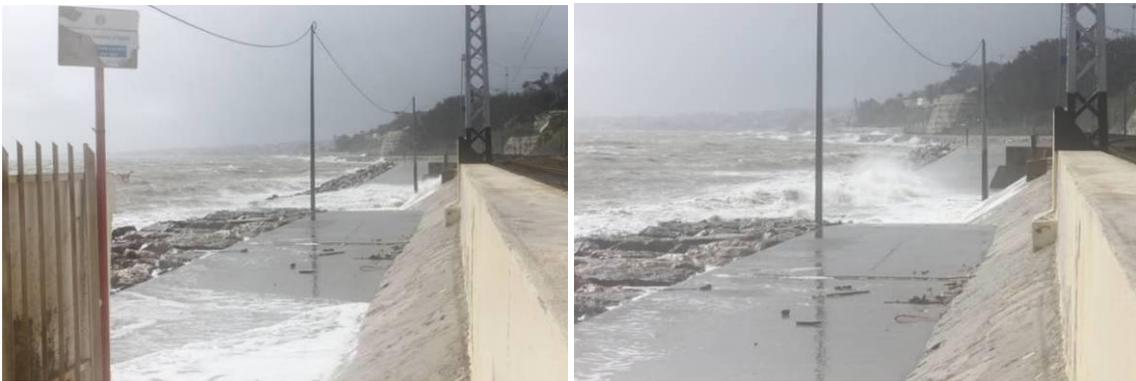
Figura 35 – Galgamento do enrocamento e passeio marítimo (Fonte: GEOTPU, 2010)
