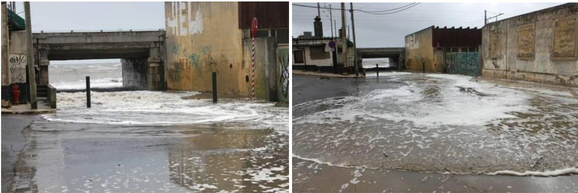
Figura 36 – Inundação da passagem inferior pedonal (Fonte: GEOTPU, 2010)
