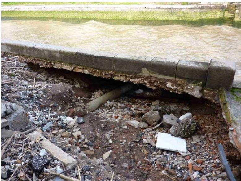
Fotografia 8 – Erosão do leito de cheias na margem direita do rio Jamor entre a ponte da Av. Marginal e a ponte da REFER (vista para montante).
