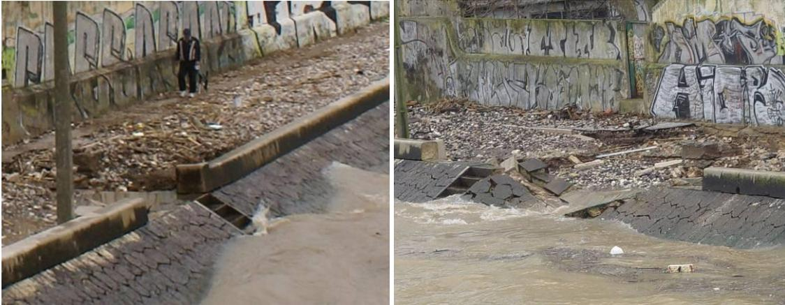
Figura 38 - Inundação e destruição das margens de protecção do Rio Jamor, foto à esquerda no dia 24 de Fevereiro de 2010 e foto à direita no dia 27 de Fevereiro de 2010 (Fonte: GEOTPU)
