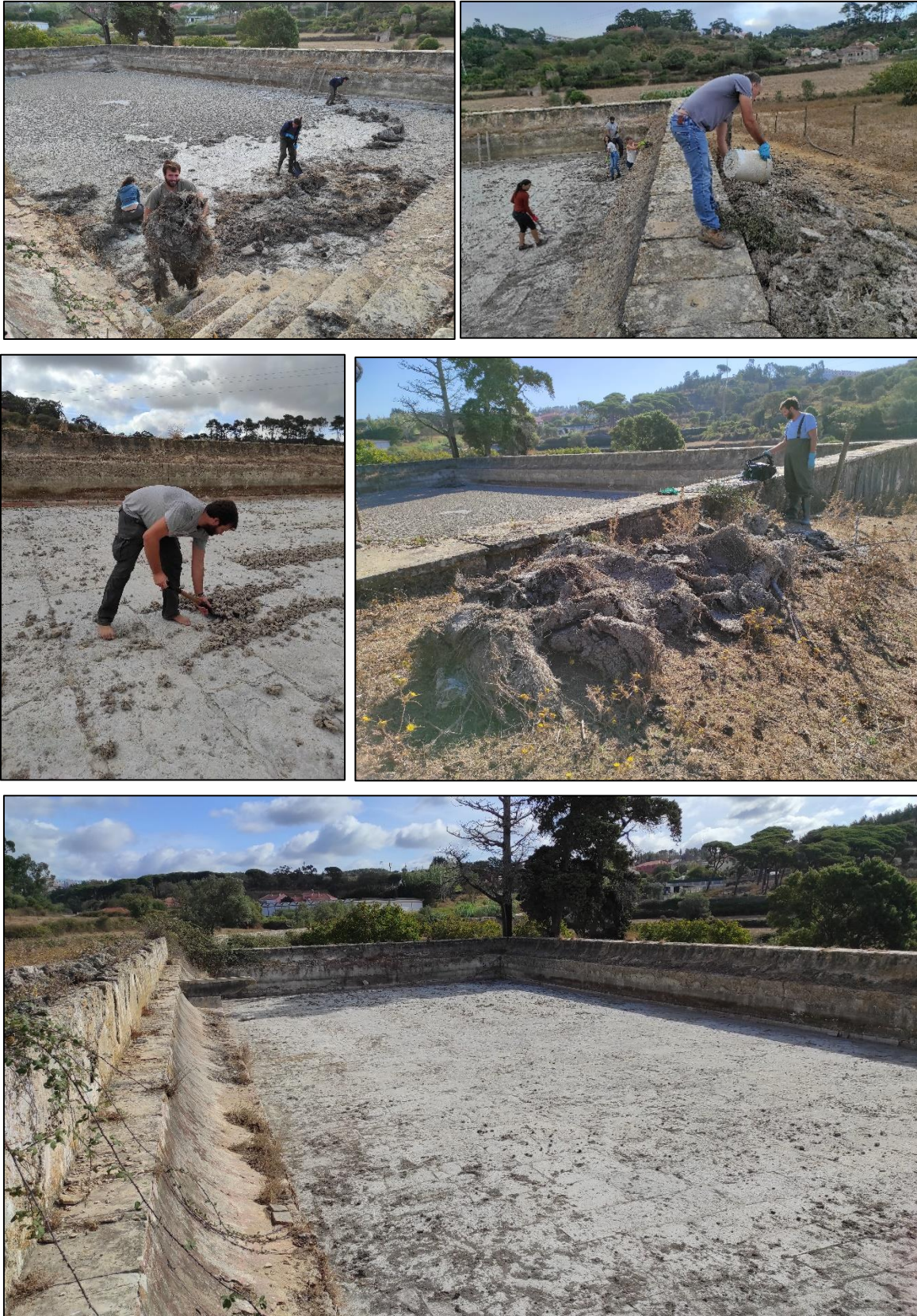
Figura 13. Limpeza do sedimento seco do Tanque do Perfume
