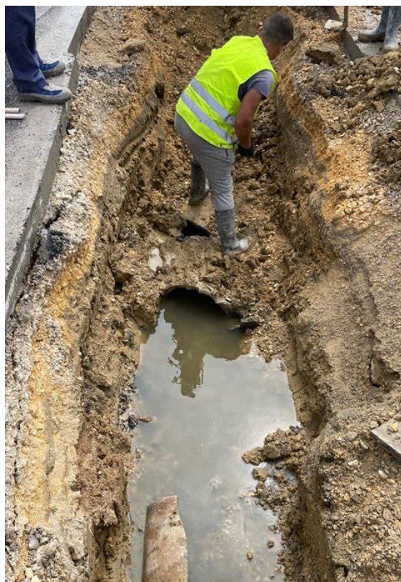
Substituição do coletor doméstico em PVCC DN200 na Avenida Marginal em Oeiras
