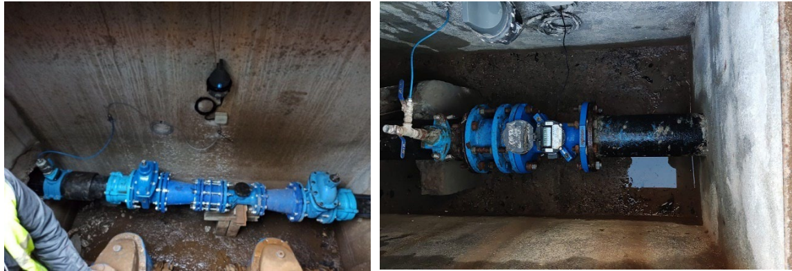
Instalação de novas Válvulas Redutoras de Pressão
