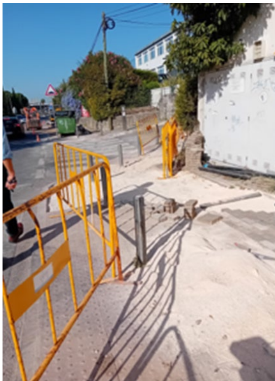
Substituição das redes de abastecimento na Estrada de Alfragide – Amadora
