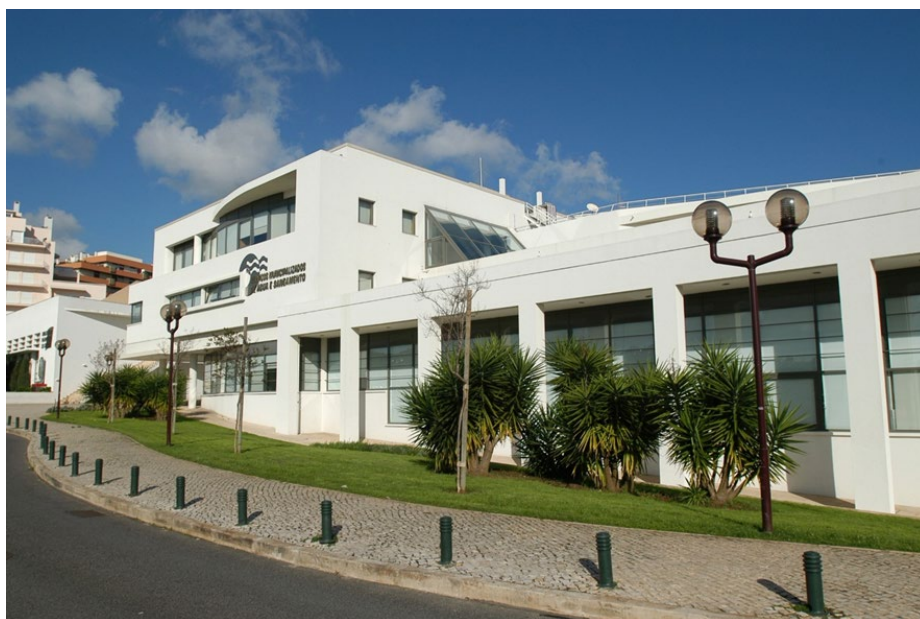
Edifício Sede dos SIMAS em Oeiras
