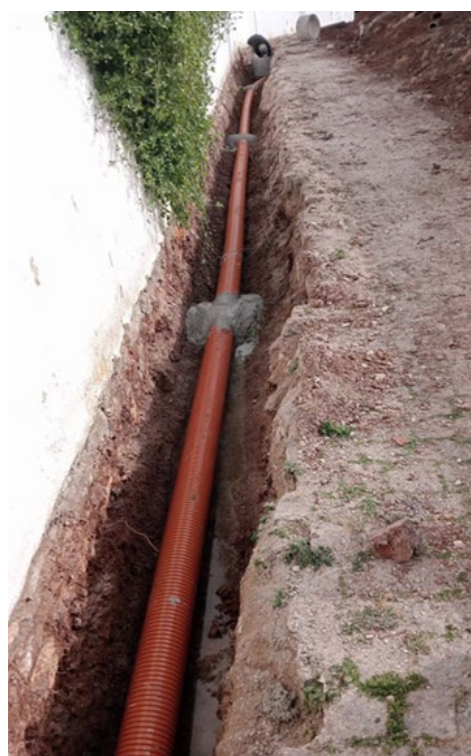
Execução de coletor doméstico PVCC DN160 na Travessa Visconde Moreira de Rey em Carnaxide
