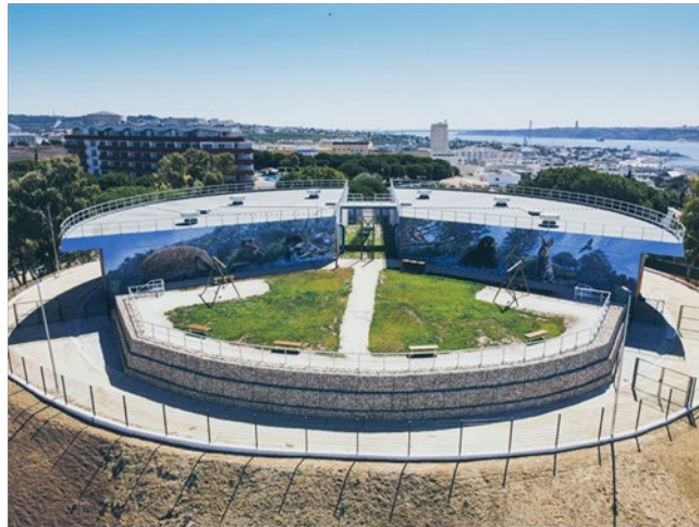
Miradouro e Mural do novo Reservatório do Alto de Santa Catarina, no concelho de Oeiras
