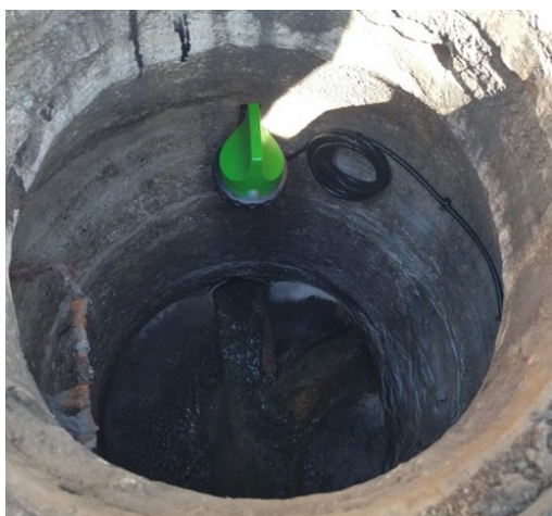
Instalação de sensores de caudal
