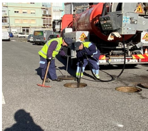
Intervenção dos funcionários dos SIMAS nas tarefas de inspeção CCTV
