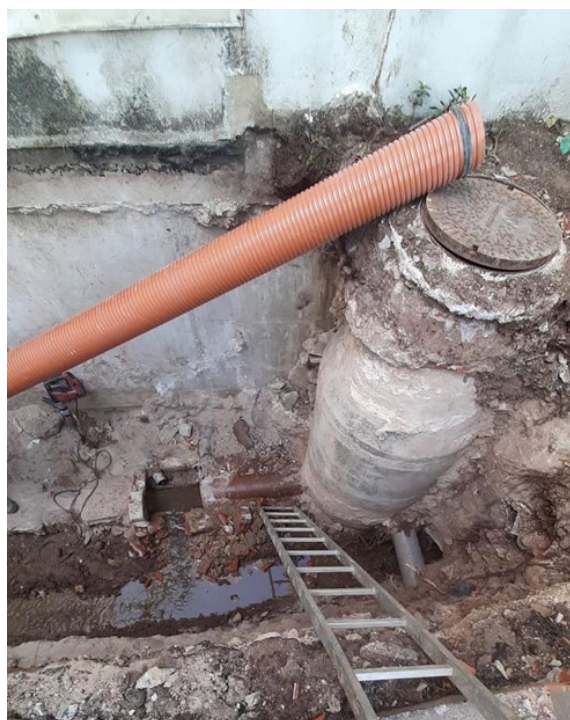
Substituição do coletor doméstico e em PVCC DN200 na Rua da Piscina em Miraflores
