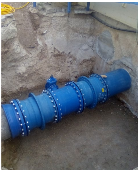
Alteração da Câmara de Manobras do Reservatório Figueirinha - Oeiras
