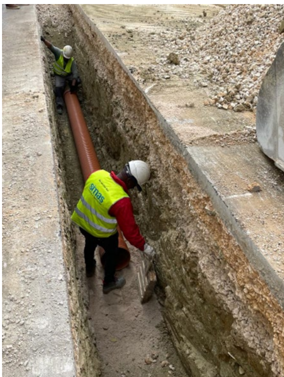
Substituição do coletor pluvial em PVCC DN315 na Rua Quirino da Fonseca em Linda a Velha
