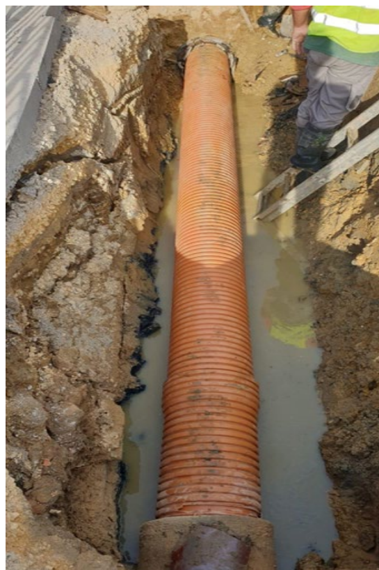
Substituição do coletor doméstico em PVCC DN200 na Avenida Marginal em Oeiras
