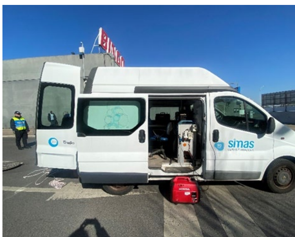
Intervenção dos funcionários dos SIMAS nas tarefas de inspeção CCTV
