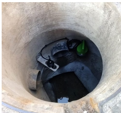
Instalação de sensores de caudal
