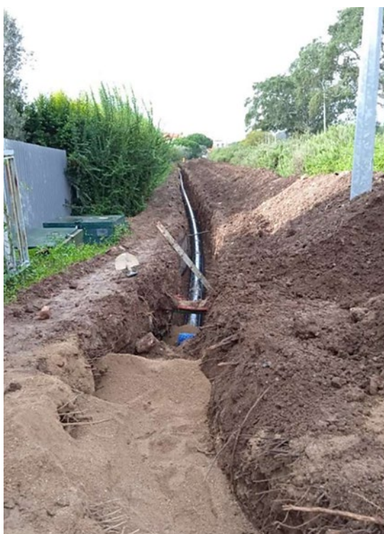
Substituição da conduta distribuidora da ZMC Carnaxide-Centro - Oeiras
