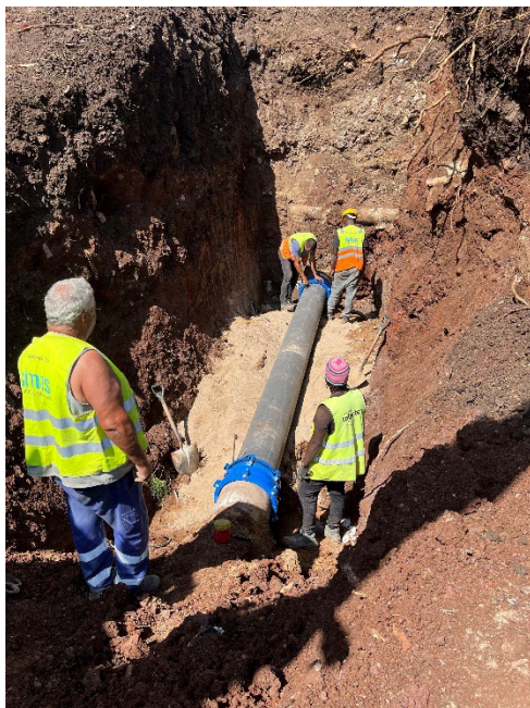
Reparação de rotura na rede de água, em conduta de diâmetro 400 mm em fibrocimento Estrada do Zambujal, junto ao IKEA, na freguesia de Alfragide
