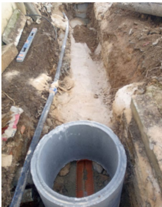
Execução do coletor doméstico em PVCC DN160 na Avenida D. João I em Oeiras
