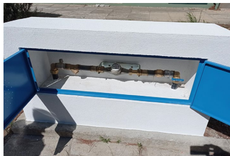
Remodelação de instalações de contador de jardim
