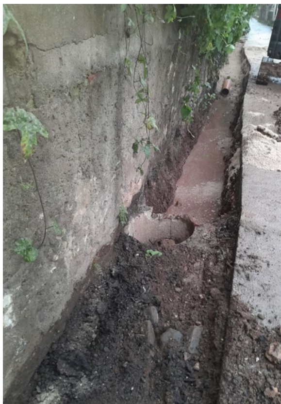
Substituição do coletor doméstico em PVCC DN200 na Rua Joaquim Sabino de Sousa
