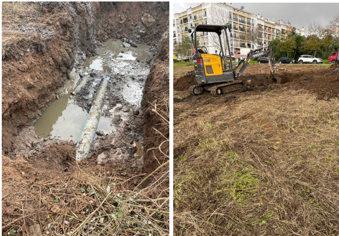
Substituição de coletor doméstico em PVCC DN200 na Rua Helena de Aragão em Tercena
