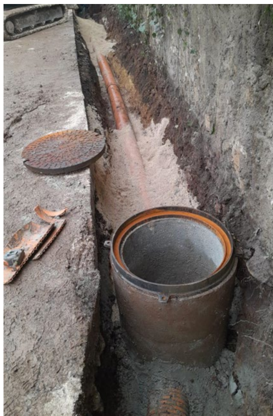
Substituição do coletor doméstico em PVCC DN200 na Rua Joaquim Sabino de Sousa
