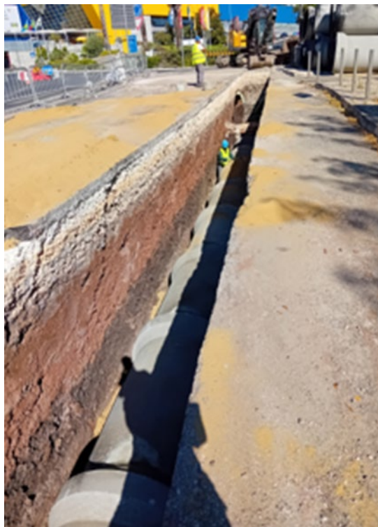
Substituição das redes de abastecimento de água e de drenagem de esgotos no Bairro do Alto do Moinho – Amadora
