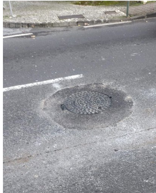
Substituição de tampas das caixas de visita de saneamento
