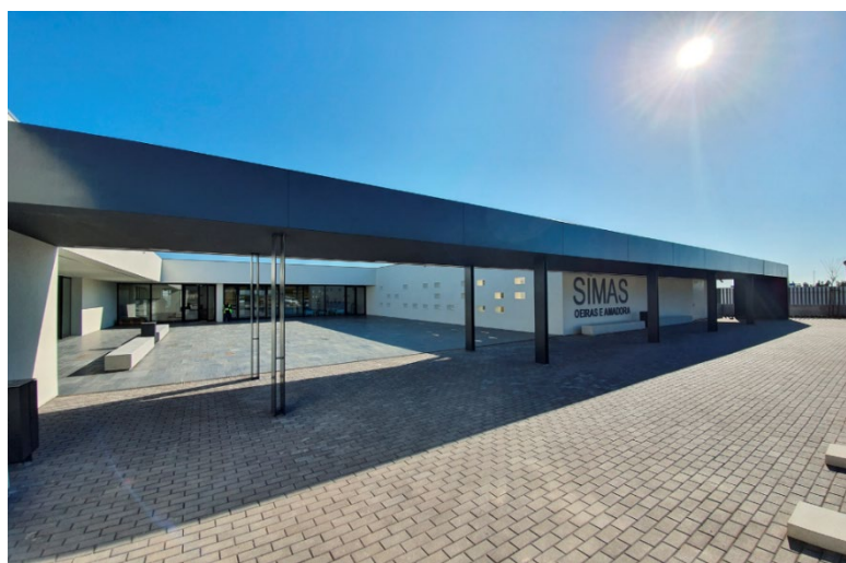
Edifício dos Serviços Técnicos dos SIMAS em Leceia
