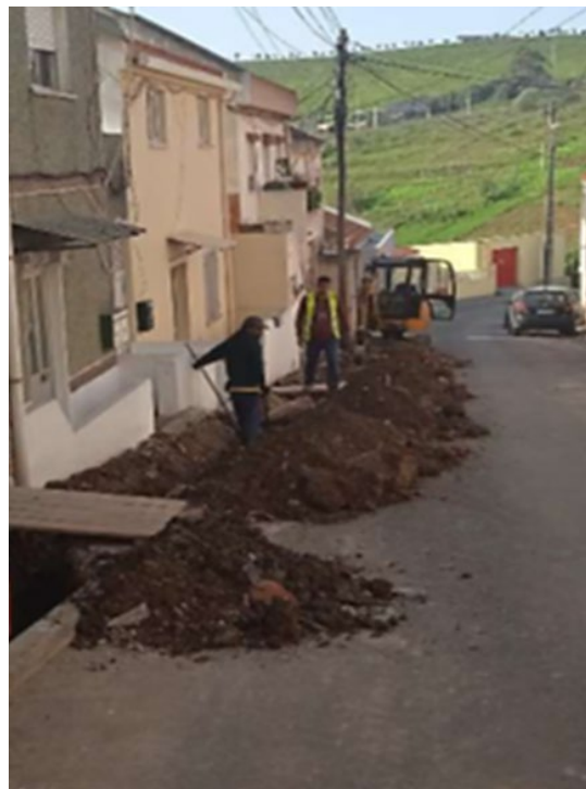
Substituição das redes de abastecimento de água no Casal da Mira, Zona Norte e Zona Sul - Mina de Água - Amadora
