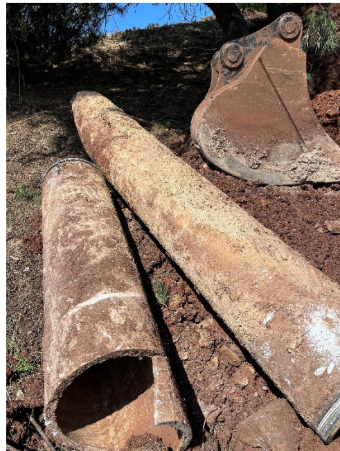
Reparação de rotura na rede de água, em conduta de diâmetro 400 mm em fibrocimento Estrada do Zambujal, junto ao IKEA, na freguesia de Alfragide
