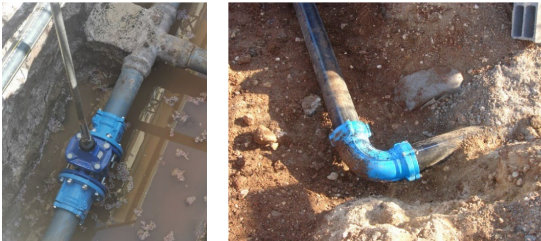
Reparação de roturas na rede de água
