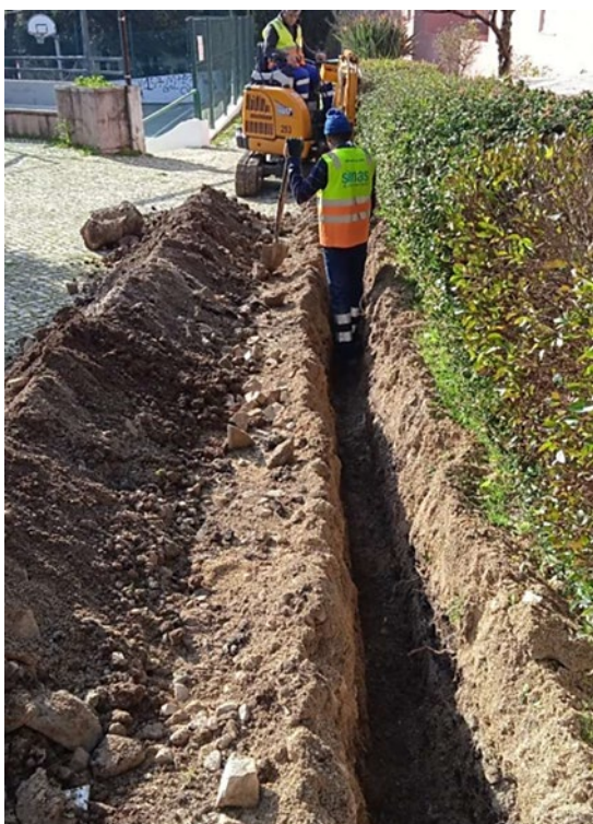
Alteração de Conduitas Distribuidoras e Renovação/ Substituição da Rede Existente no Subsistema de Carnaxide - Fase 3 – Oeiras
