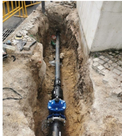
Remodelação de redes de abastecimento de água
