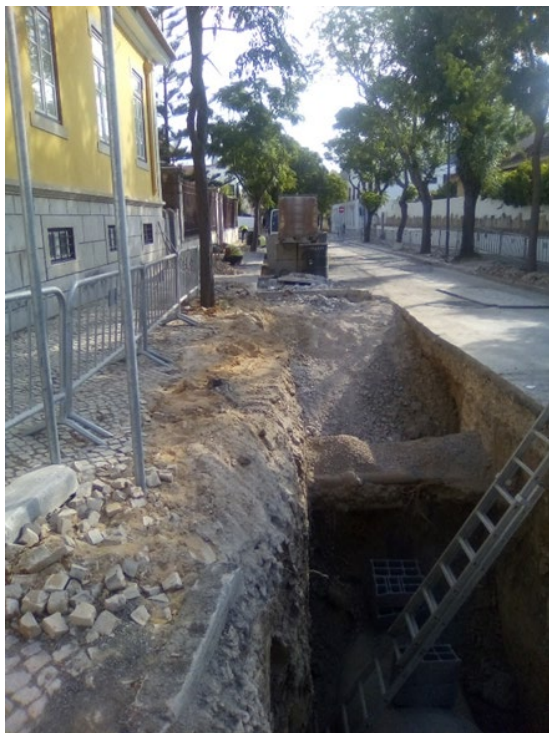
Substituição das redes de saneamento na Av. Salvador Allende - Caxias - Oeiras
