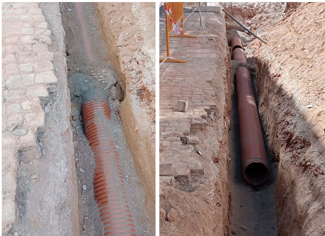
Substituição do coletor pluvial em PVCC DN200 na Rua Joaquim Patrão Lopes em Paço de Arcos
