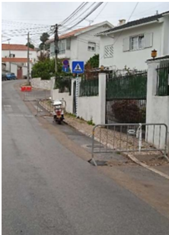
Substituição das redes de abastecimento de água na Rua José Basaliza e arruamentos confinantes - Valejas - Oeiras
