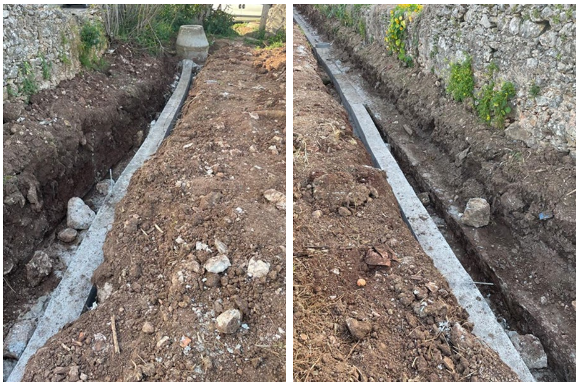
Substituição do coletor doméstico em PVCC DN200 na Estrada de Laveiras, Caminho do Rio em Caxias
