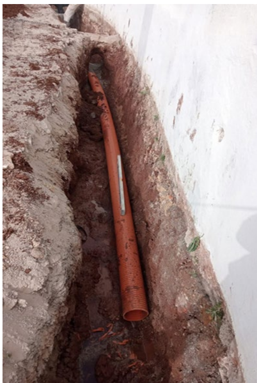
Execução de coletor doméstico PVCC DN160 na Travessa Visconde Moreira de Rey em Carnaxide
