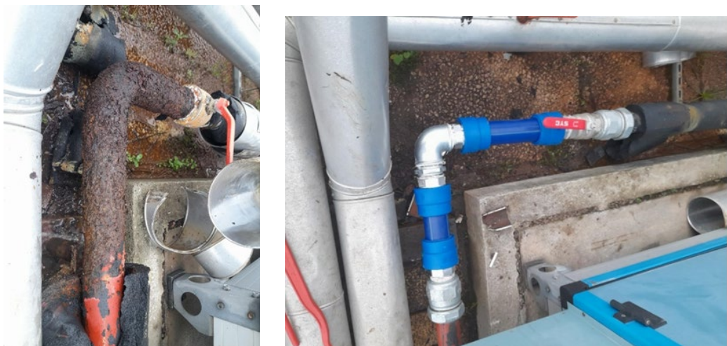
Reparação de rotura nas condutas do sistema de ventilação, do edifício Sede
