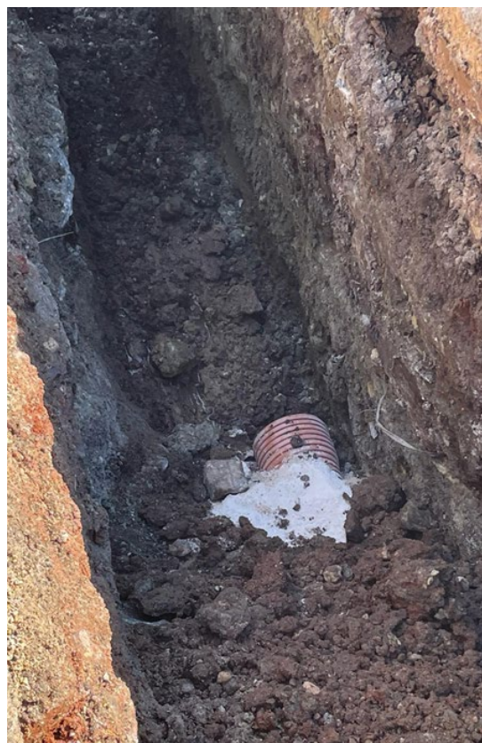
Substituição do coletor doméstico em PVCC DN200 na Avenida Eng.º José Mattos Silva em Miraflores
