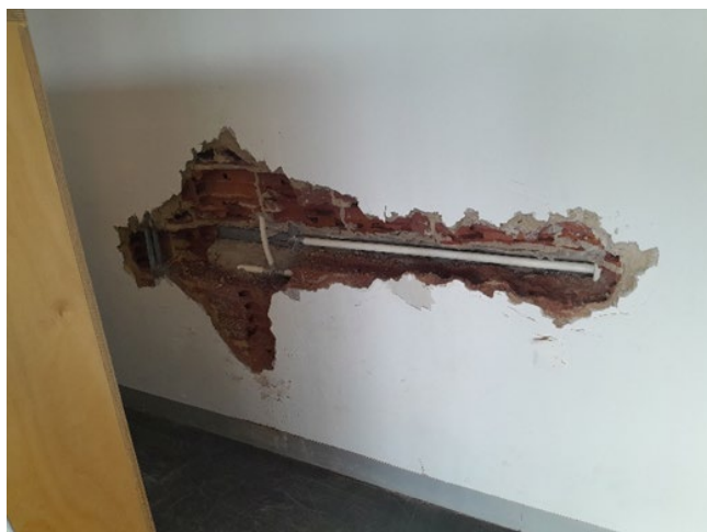
Reparação de tubagem no edifício dos Serviços Técnicos da Brandoa
