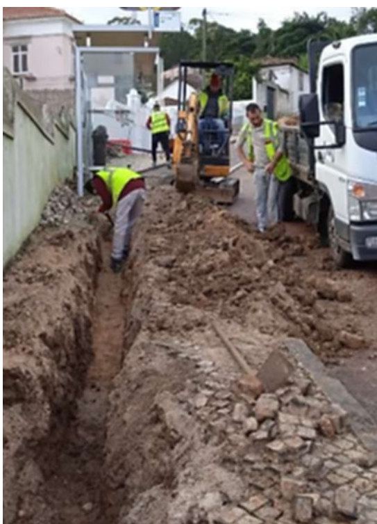
Substituição das redes de abastecimento de água na Rua D. Manuel I e Rua 7 de Junho - Barcarena - Oeiras
