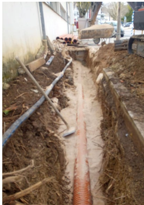
Execução do coletor doméstico em PVCC DN160 na Avenida D. João I em Oeiras
