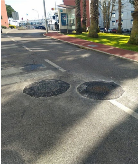
Substituição de tampas das caixas de visita de saneamento
