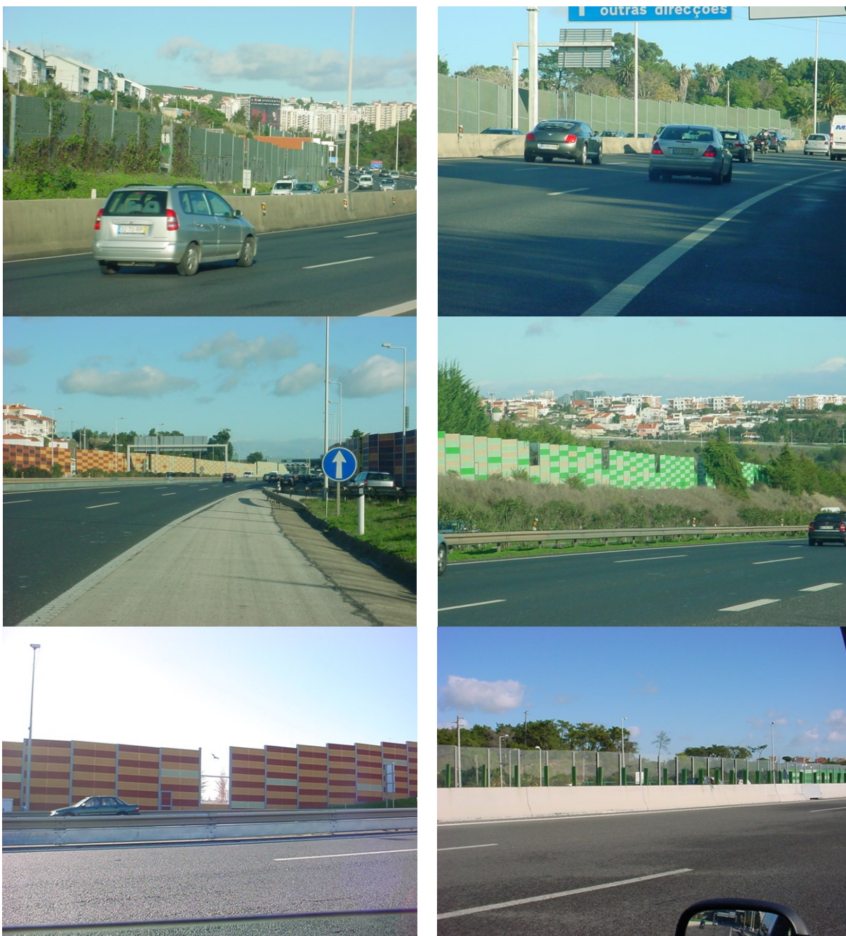
Figura 6-1 – Exemplos de barreiras acústicas de diversos tipos na A5.
