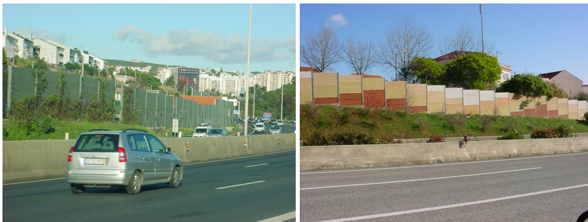
Figura 3- Exemplo de barreiras acústicas na A5 (à esquerda) e na A9 (à direita).
