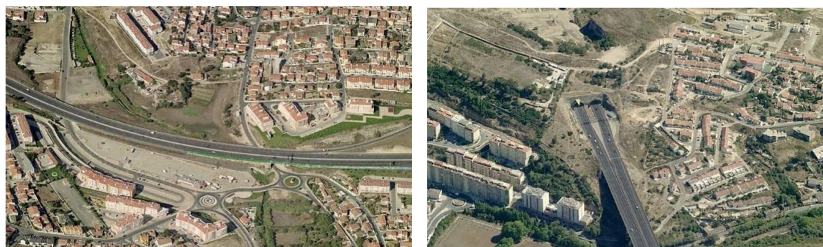
Figura 2- Imagens aéreas da A5, na zona de S. Domingos de Rana, Cascais (à esquerda), e da A9, vendo-se o túnel de Carenque, Sintra (à direita)
