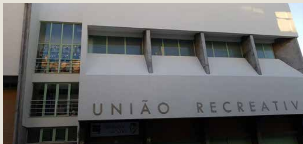
Requalificação da fachada do Edifício da União Recreativa do Dafundo
