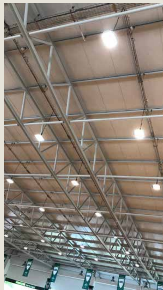
Substituição de iluminação do Pavilhão Desportivo CRLPS
