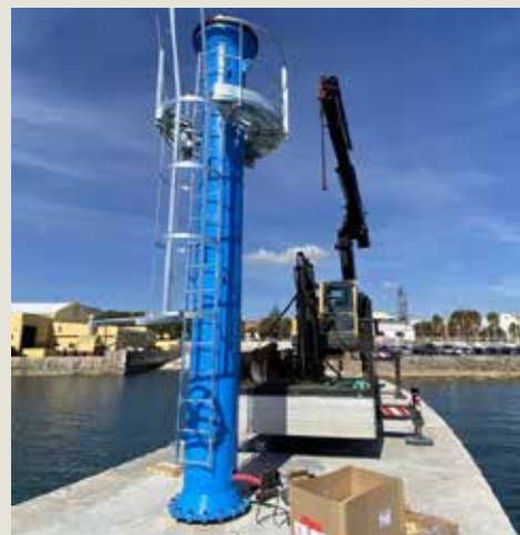
Substituição de grua do Centro Náutico do CDPA
