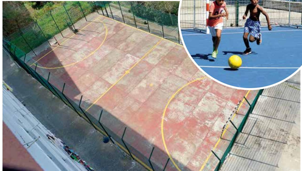
O passar do tempo e a erosão inerente a terrenos com inclinação foram determinantes no processo de degradação das grelhas de enlramento colocadas no início e também no pavimento de resina e inertes.
