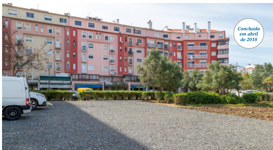
Demolição do edifício do Grupo Recreativo e Desportivo 'Os Fixes', em Queluz de Baixo
