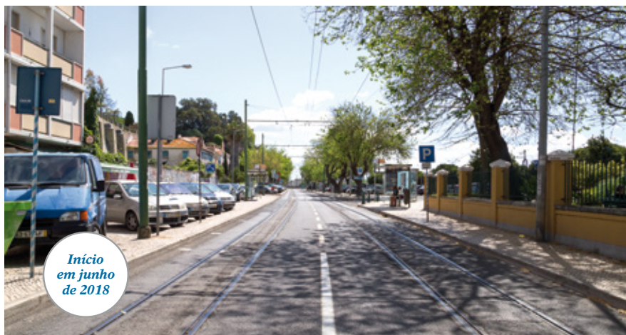
Reformulação da Rua Sacadura Cabral, na Cruz Quebrada
