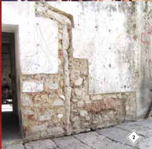
1. Ferrarias del Rey. Limpeza da parede da galeria dos engenhos de concreções e sedimentos, em 2007, com o objectivo de identificar elementos estruturais de distintas épocas de construção.
