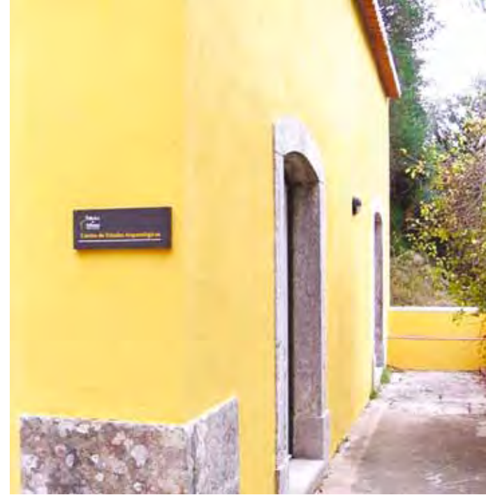
Vista parcial do piso térreo do edifício do Centro onde se encontra instalado o Laboratório e o Depósito de Materiais Arqueológicos.
