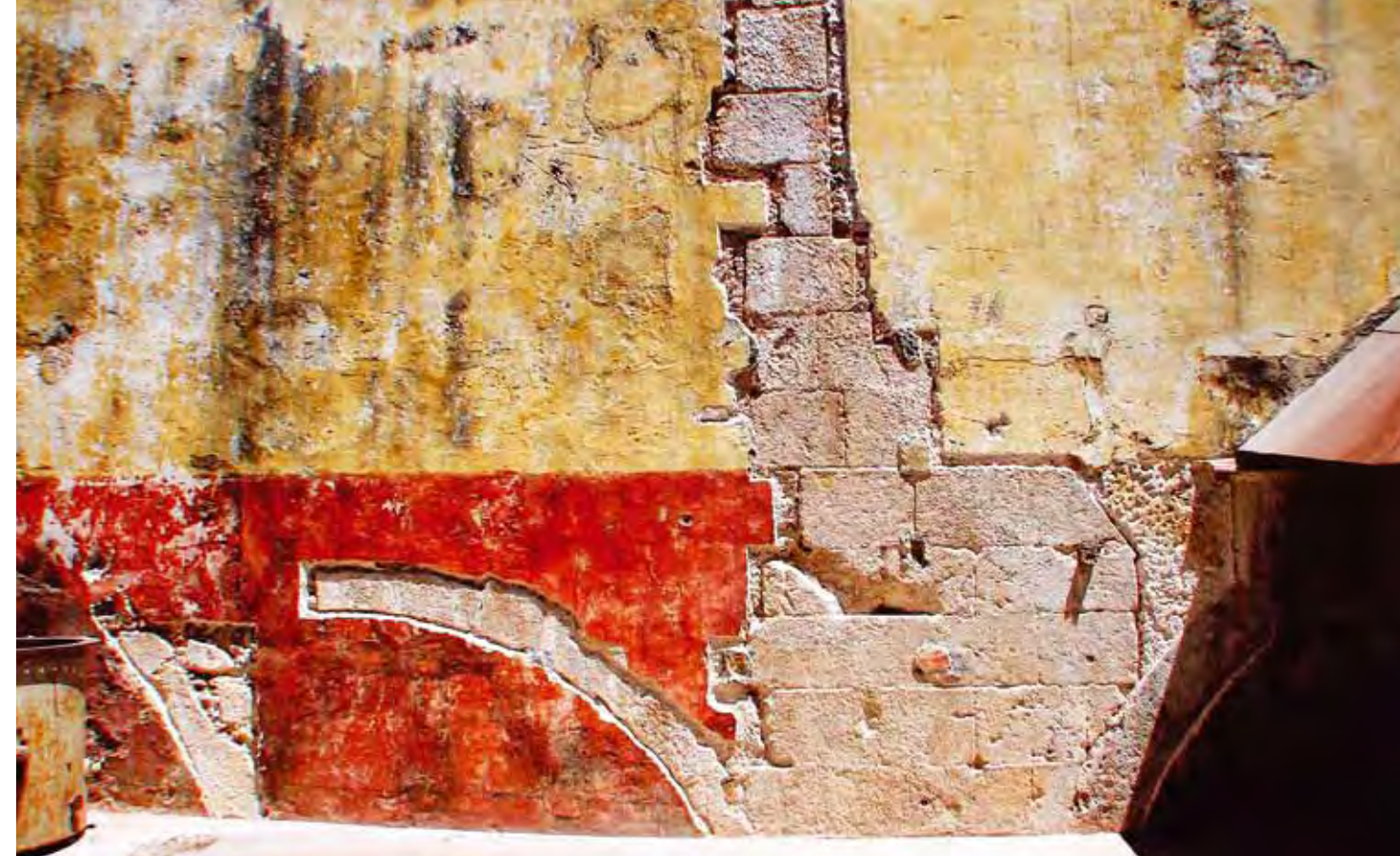
Aspecto dos trabalhos conducentes à identificação de diversas fases construtivas no edifício das antigas “Ferrarias d’El Rey”, em 2007, com base em planta de Leonardo Turriano, que se manteve inédita até 2005, ano em que foi publicada, por J.L. Gomes e pelo signatário.
