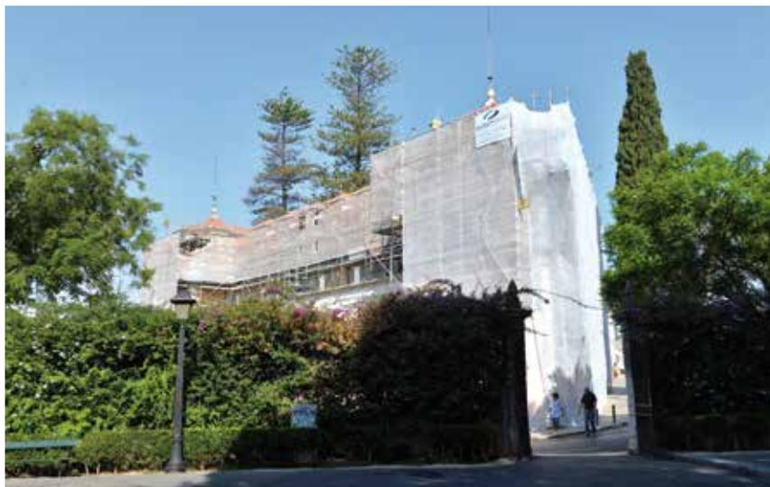
Concluída a obra no terraço norte, tiveram início durante o verão os trabalhos de reabilitação do terraço sul, substituição de beirados e reconstrução de cimalhas, investimento que ascende aos 134 mil euros.
