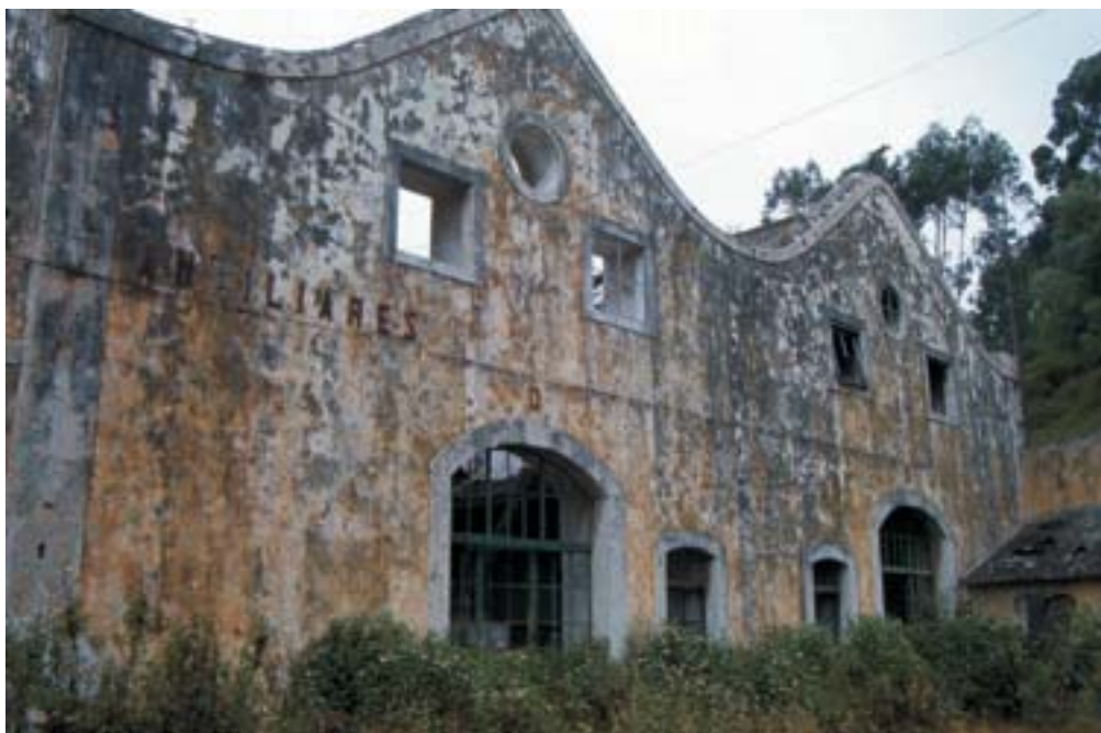
Fig. 16 – Fachada principal dos velhos edifícios que ocupam actualmente o espaço pertencente às antigas Ferrarias del Rey .
