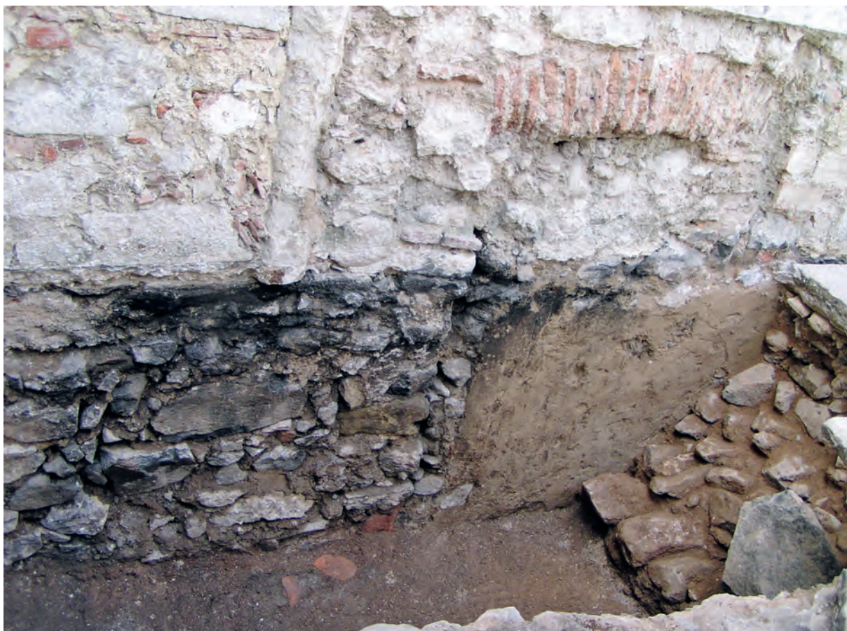
Fig. 22 – Ferrarias del Rey . Vista parcial do interior da parede poente do edifício primitivo, evidenciando-se a diferença de rebocos entre o sector correspondente à porta entaipada e a parede adjacente. Observe-se um dos muros contraventados que contribuíam para a estabilidade da abóbada do engenho de galgas, construídos entre o exterior desta e a parede do edifício (ver Figs. 4 e 13).
