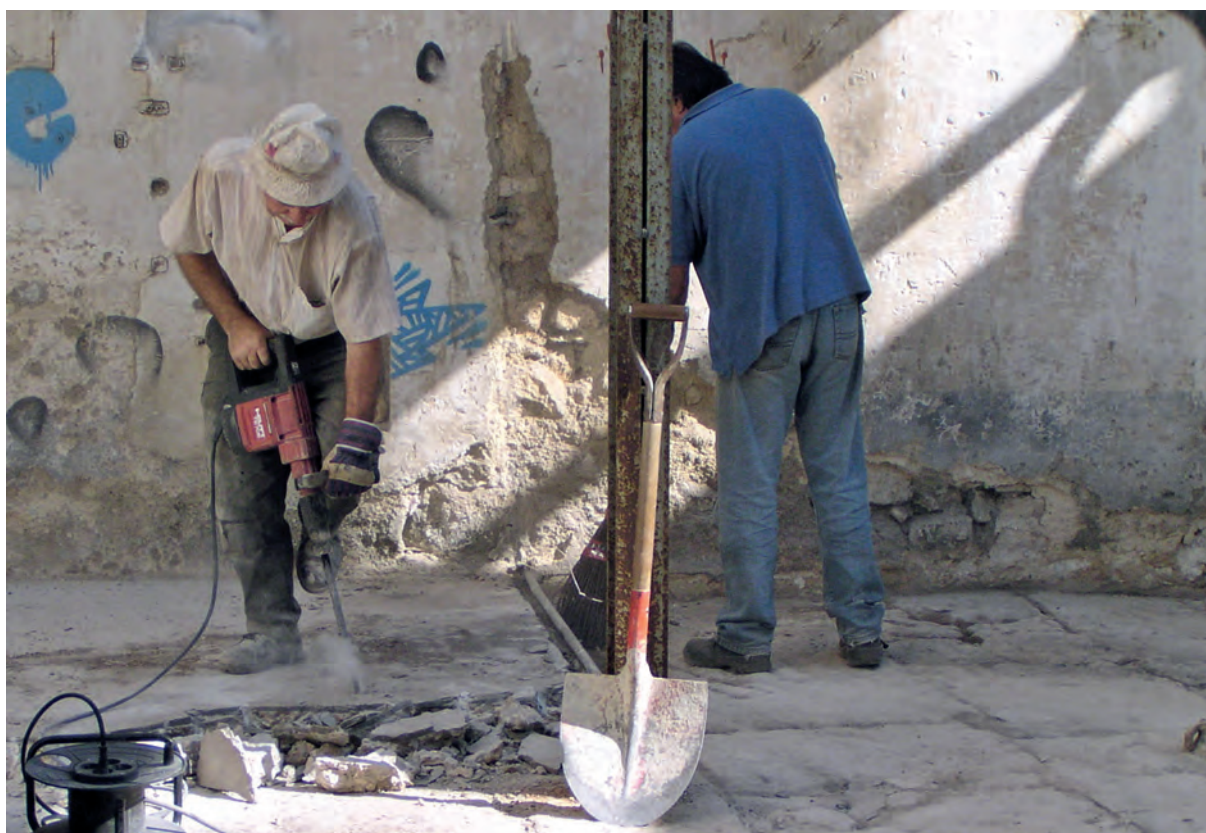
Fig. 6 – Ferrarias del Rey . Pormenor da remoção do piso de betonilha, com martelo pneumático, que forrava completamente o chão lajeado das Oficinas D e E do Edifício 33.
