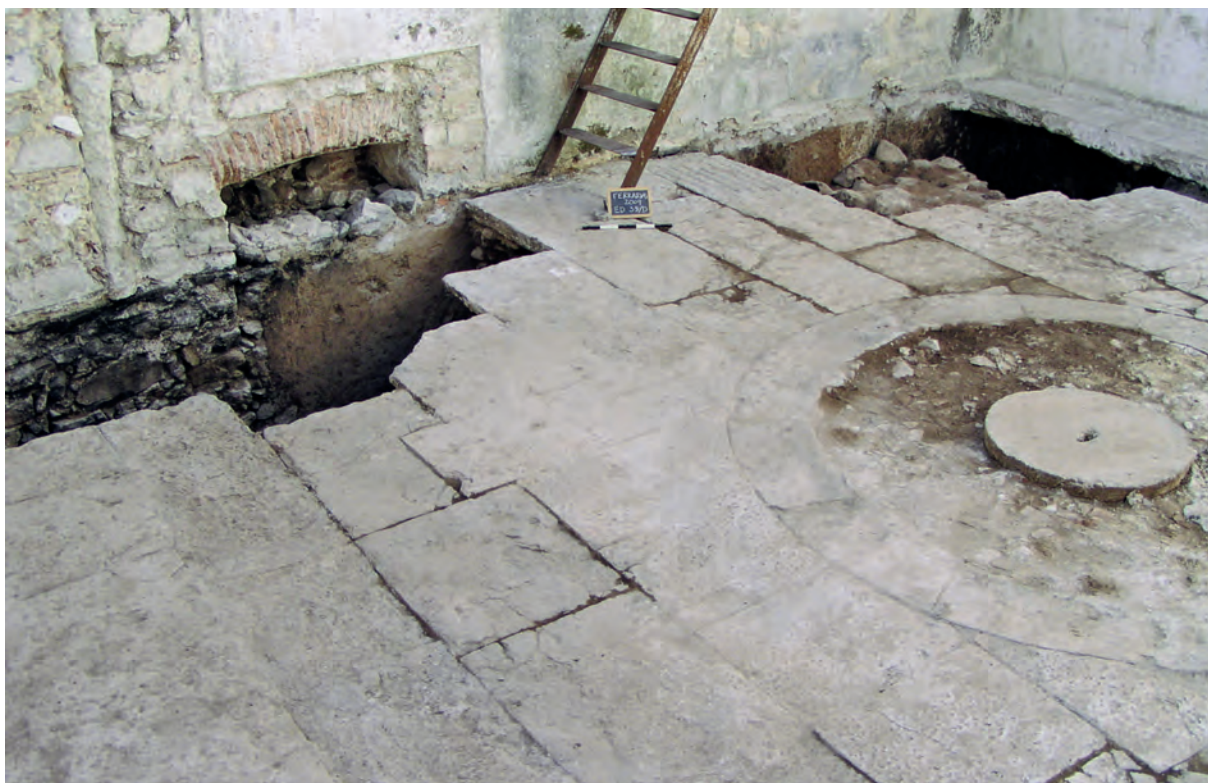
Fig. 11 – Ferrarias del Rey . Vista parcial da Oficina D (Edifício 33), depois de concluídos os trabalhos. Evidencia-se o revestimento de grandes lajes, forrando integralmente o chão da antiga oficina da pólvora do século XVIII, em cujo centro se localizava o suporte do prato onde giravam as galgas. Ao longo da parede poente, observam-se os dois locais onde em 2009 se efectuaram sondagens arqueológicas, bem como a verga da porta do antigo edifício das Ferrarias (ver Fig. 4).
