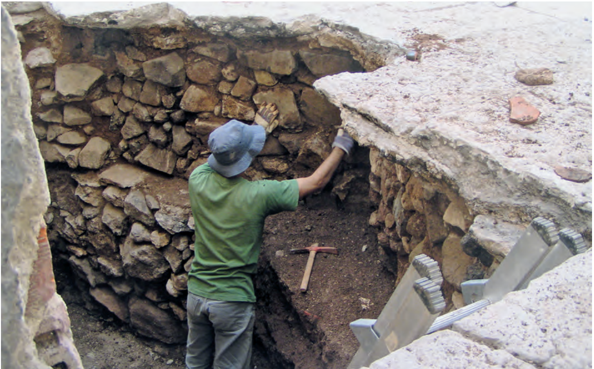
Fig. 12 – Ferrarias del Rey . Aspecto do revestimento externo da abóbada de alvenaria de suporte ao engenho de galgas, da fábrica da pólvora do século XVIII, enterrada sob o piso da oficina. Note-se as duas etapas construtivas, representadas pelo ressalto do revestimento do lado esquerdo da foto.
