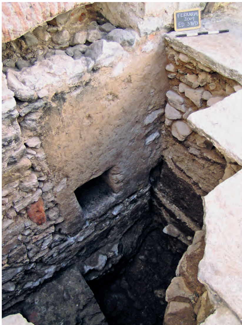
Fig. 23 – Ferrarias del Rey . Aspecto da porta entaipada do edifício primitivo ulteriormente rebocada, observando-se as duas cavidades afeiçoadas e também rebocadas, destinadas possivelmente ao apoio e fixação dos engenhos existentes na oficina, entre os séculos XV/XVII (ver Figs. 4, 13 e 22).
