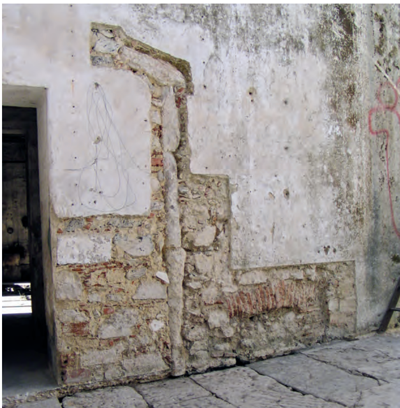
Fig. 4 – Ferrarias del Rey . Identificação, do lado direito da foto, da verga da porta do antigo edifício, em 2007, depois entulhado aquando da remodelação para fábrica da pólvora, sob a égide de António Cremer, na década de 1720/1730.
